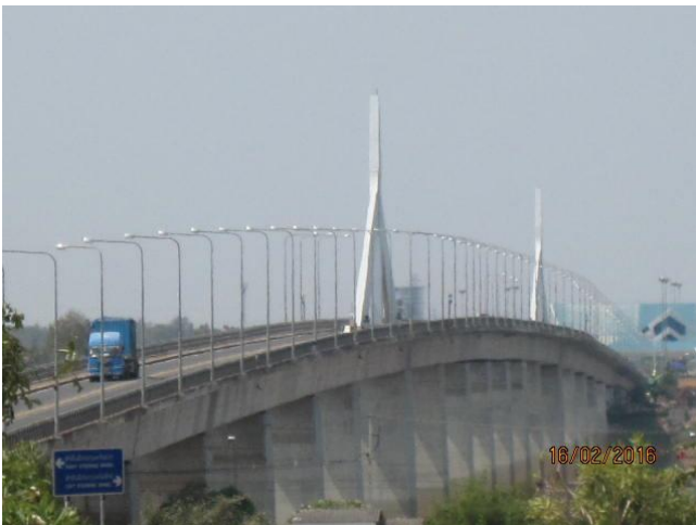
2006 年 12 月供用開始、円借款約 80 億円、 L=1,600m、W=12m (上下 2 車線)
