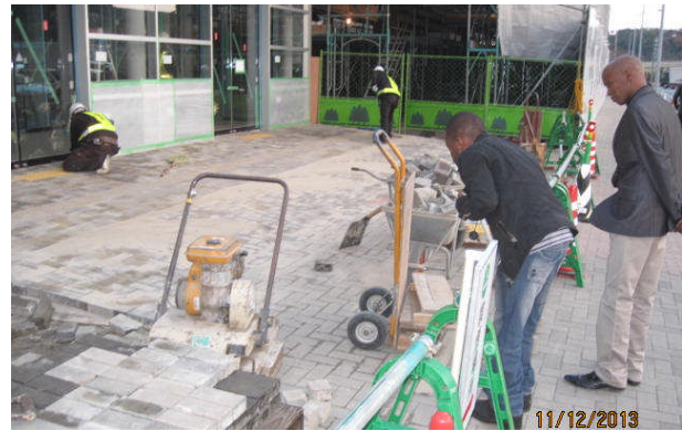
視察途上に偶然見つけた歩道舗装改修工事の見学
